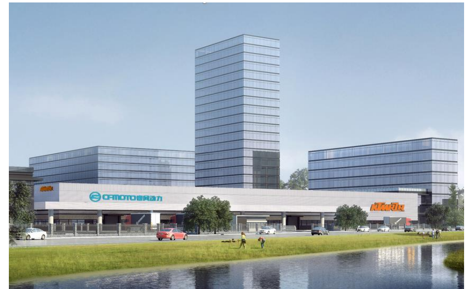
Anlage im Bau
